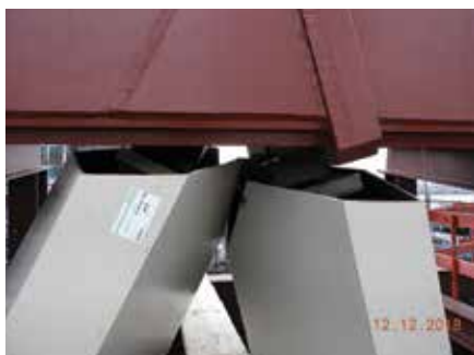
22. Scharnierverbinding op aansluiting met kokerligger 4 e verdieping
