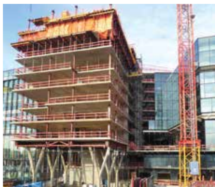
9. Woongebouw ondersteund door Y-kolommen en tafelconstructie.
