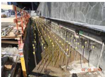
23. Ingelijmde stekken ( \varnothing 20 , h.o.h. 200 mm in beide richtingen) voor opstorting op de bovenzijde van de bestaande kelderwandconstructie.
