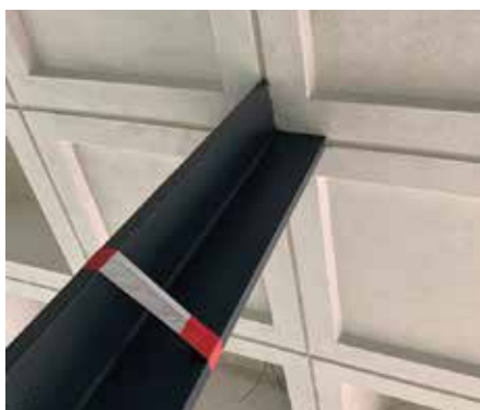
31. Cassettevloer ondersteund door kruisvormige stalen kolom.
