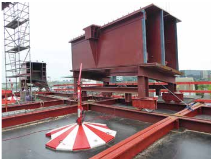
19. Segment van kokervormige ligger noordgevel op tijdelijke constructie.
