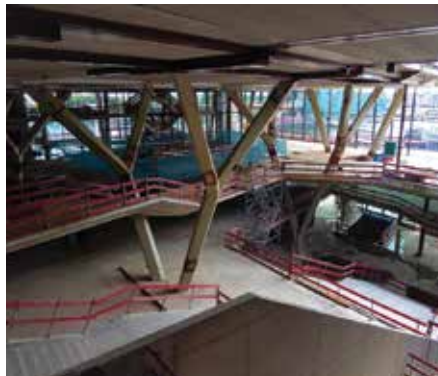
29. Boom- en V-kolommen onder 4 e verdiepingvloer.
