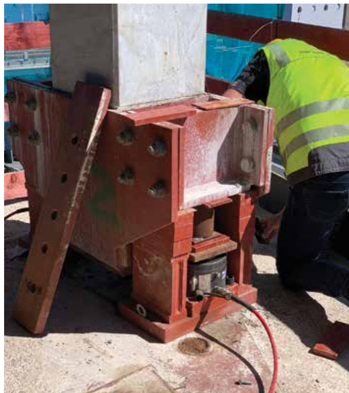
25. Vijzels ter weerszijden van betonkolom direct boven niveau 4 e verdieping.
