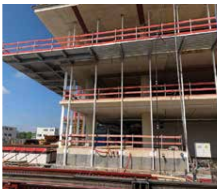
33. Uitkragende balkonconstructie aan oost- en zuidgevel op niveau 2 e verdieping.
