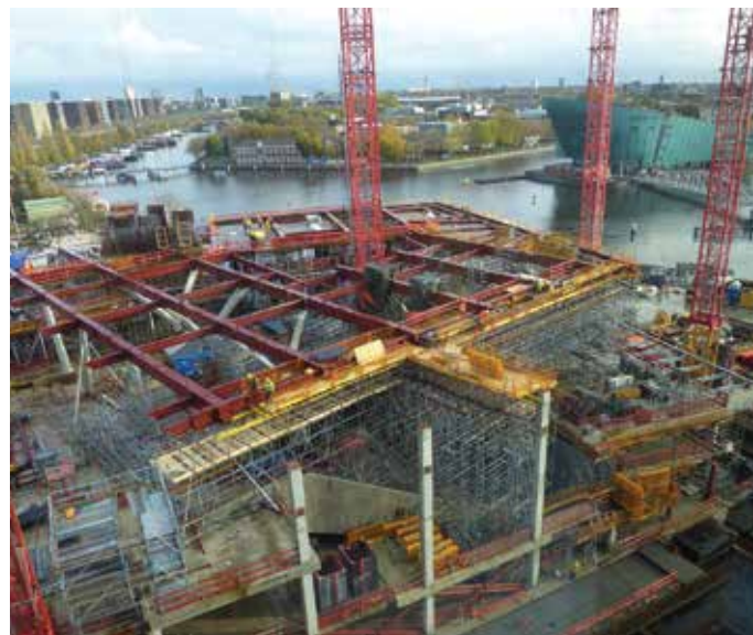
27. Tafelconstructie 4 e verdieping vanuit bouwkraan (bron: ODE magazine 3).
