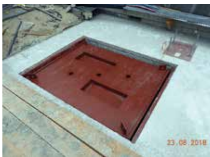
24. Inkassingen in opstorting op de bestaande kelderwandconstructie voor voeten W-kolommen.
