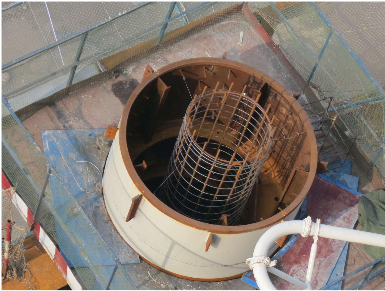
图 1. 钢管混凝土柱施工照片
