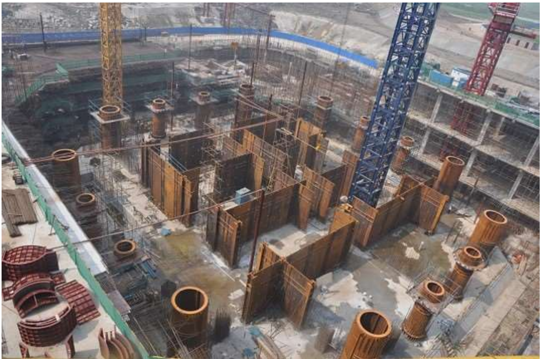
图 2. 钢板混凝土剪力墙施工照片
